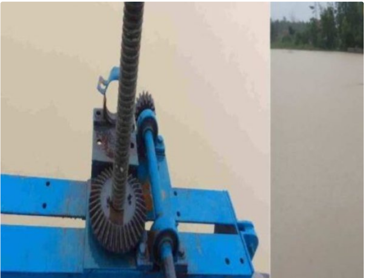
Pintu air Albaret Simpang Mesuji
